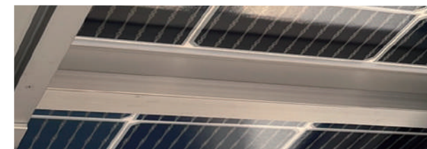
雨水受け (二次受け) を設置
